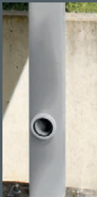
Entwässerung durch Stütze
