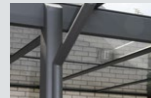
Tebau MaxPlus in Dachfarbe beschichtetes Aluminiumfallrohr
